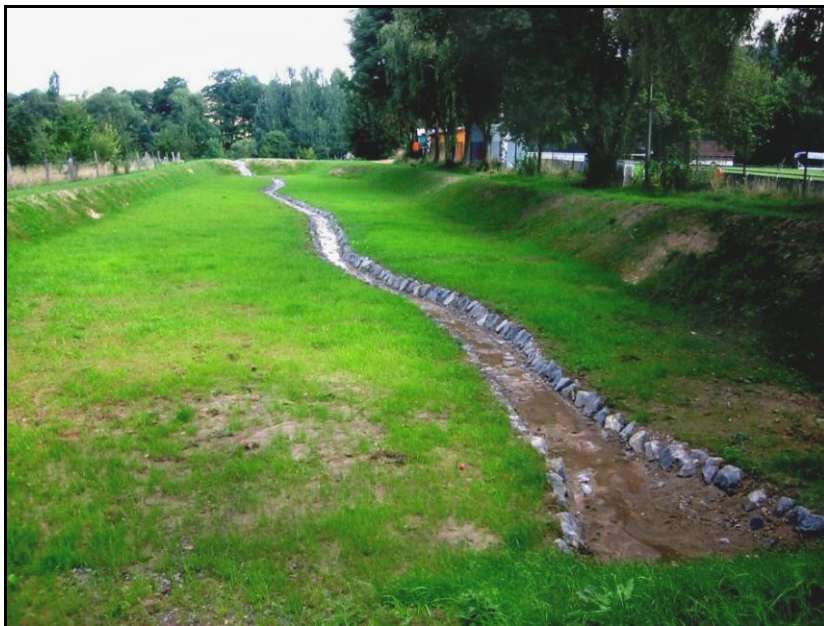
Abbildung 2: Beispiel für ein Regenrückhaltebecken (Quelle: Ingenieurbüro Lorenz)
